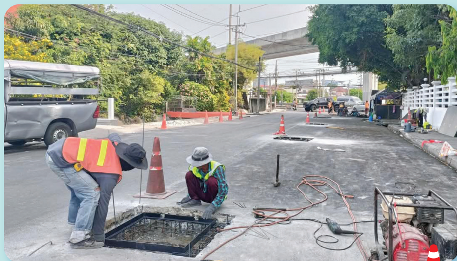
ติดตั้งฝาเหล็กหล่อ ยกระดับเสริมขอบบ่อพัก
