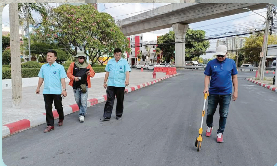
ติดตามความคืบหน้าการดำเนินงานปรับปรุงผิวจราจร
