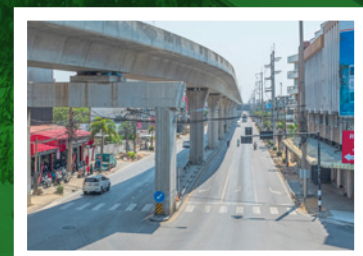
โครงการปรับปรุงทางเดินเท้าถนนสุขุมวิท บริเวณแยกหอนาฬิกา-แยกการไฟฟ้า อ่านต่อหน้า 10
