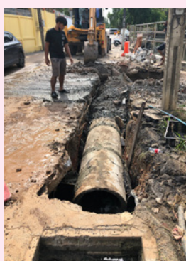
วางท่อลอดเพื่อรับน้ำจากวัดชัยมงคลและชุมชนคลองตาเค็ดฝั่งตะวันออก
